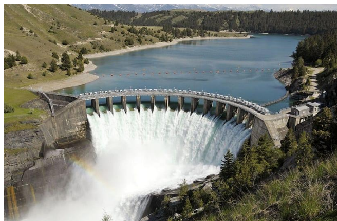
Imatge 4. Central hidroelèctrica. Imatge extreta de https://www.renovablesverdes.com
